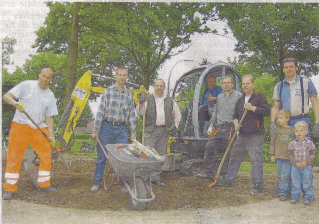
Im Einsatz für die Roxeler Bürgerschaft: Den Parkplatz zwischen Hallenbad und BSV-Tennisanlage verwandelten die St.-Pantaleon-Schützen rechtzeitig zum Schützenfest in einen schmunken Festplatz.
